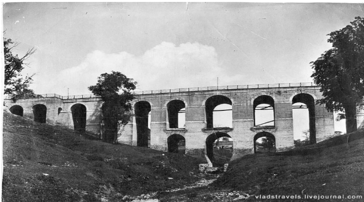
Рисунок 2 – Каменный мост через Березуевский овраг (г. Калуга)
