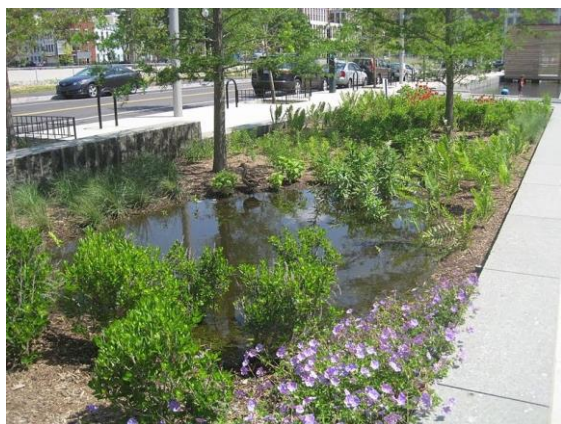
Рисунок 2 – Примеры устройства дождевого сада с верхним устилающим слоем из древесной мульчи
