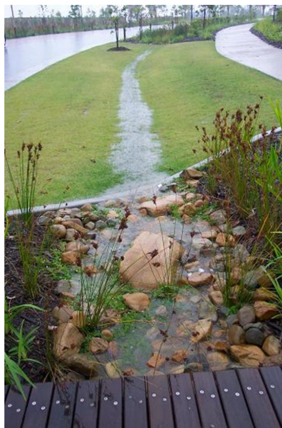
Рисунок 2 – Пример устройства фитоочистной системы
